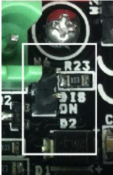
Colocar el puente en DIS ON
